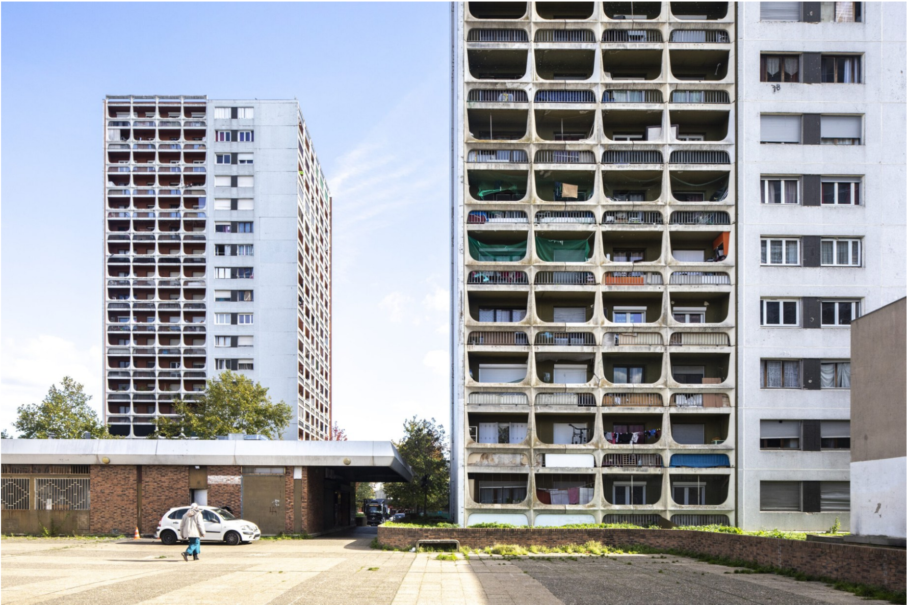
© ORCOD EPFIF 2024 EPPC / AMO transformation de la Dalle Clémenceau et centre commercial Mantes 2
